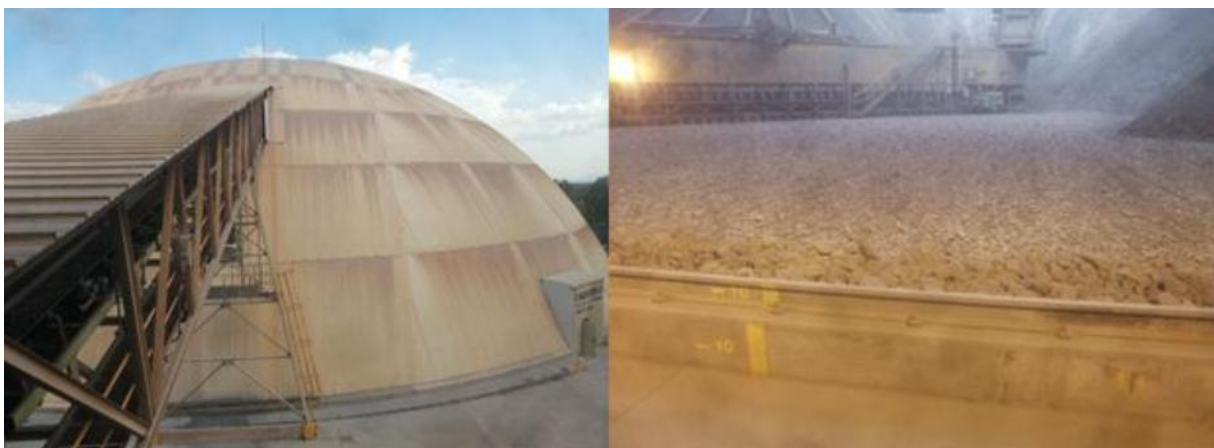
Ilustración 5. Almacén Pre-Homogeneizador de cañiza de mezcla.
